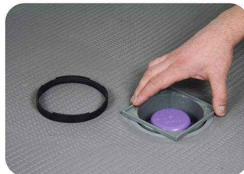
L'ajustement précis de la hauteur peut s'effectuer lors de la pose du carrelage. Une fois que la grille en inox a été installée, le receveur peut être carrelé.
