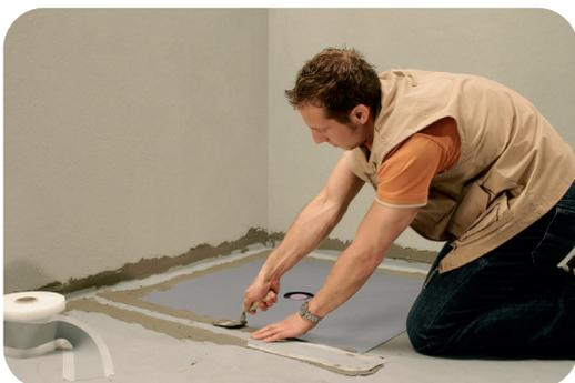
Alle Stoßfugen werden mit dem Qboard® Abdichtungsset 2-k (oder gleichwertig) abgedichtet.
