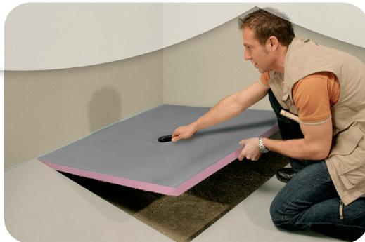
Der untere Dichtring des Duschelementes wird eingefettet. Anschließend wird das Duschelement in die Estrichaussparung eingesetzt, so dass der Ablauf in den Dichtring gleitet.
