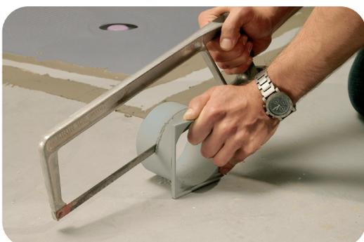
Das q-Ablaufsystem ist höhenverstellbar. Hierdurch ist gewährleistet, dass nahezu jede beliebige Fliesendicke verwendet werden kann. Hierzu wird das Aufsatzstück je nach Fliesendicke auf die gewünschte Höhe abgelängt.
