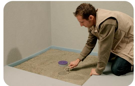
Nach dem Aushärten des Ausgleichsestrichs wird zunächst der Bauschutzdeckel vom Ablauf genommen und der PE-Ring wieder entfernt. Anschließend wird mit einem Zahnspachtel ein geeigneter Kleber (z.B. Fliesenkleber/ Flexkleber) auf die Qboard® liquid Unterseite vollflächig aufgetragen.
